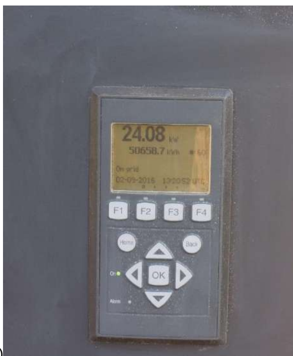
Ilustración 65: a) Vista Inversor 60kW; b) Vista panel inversor (Fuente: Visita 02-09-2016).
