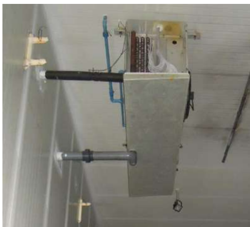
Ilustración 58 Condensadores en techo de planta Frunar (Fuente: Visita a planta 08-09-2016).
